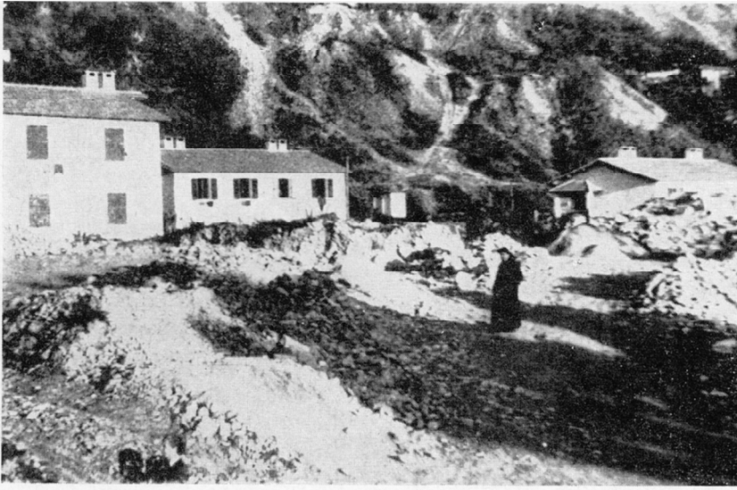
Il cumulo di rovine di Santa Maria delle Grazie nel 1944, foto tratta da Ubaldo M. Forconi, osm, Quaderni di Notizie ...
